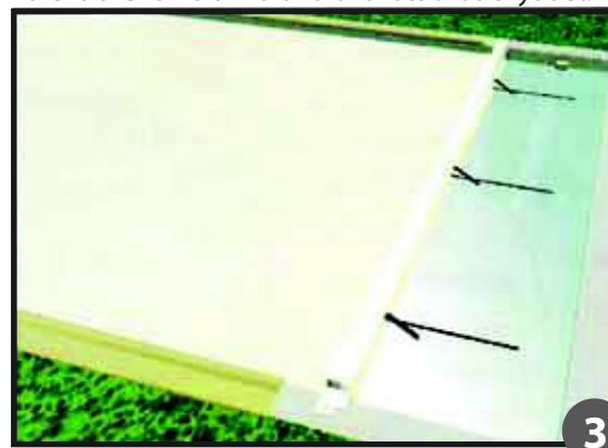
Positionnez le rideau sur la surface de l'eau. Il doit s'insérer entre la poutre et la cloison de séparation (ou le mur).
